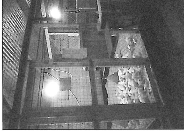
L'éclairage est assuré au moyen d'ampoules à incandescence
