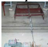
Mise en place de racleurs sous les caillebotis
