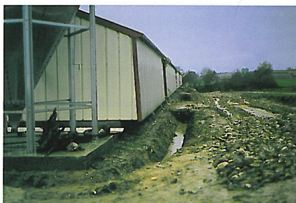
Gestion de l'eau en périphérie d'un bâtiment
