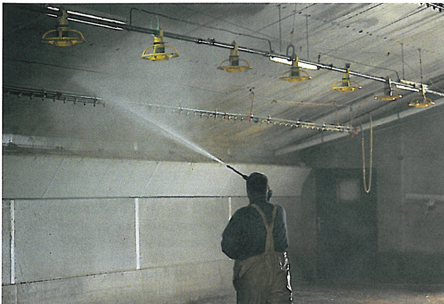
Utilisation d'une pompe à haute pression pour le lavage et le décapage
