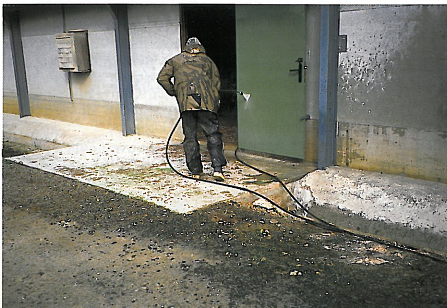
Les parties externes du poulailler sont nettoyées à la pompe à haute pression
