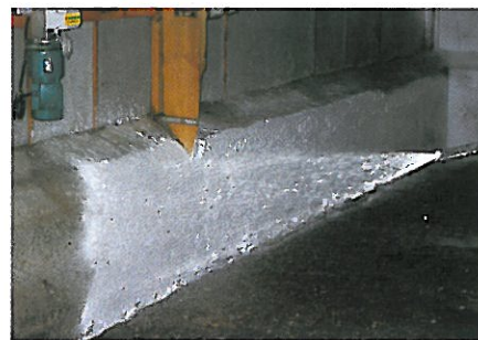
Détrempage et détergence à l'aide d'un canon à mousse
