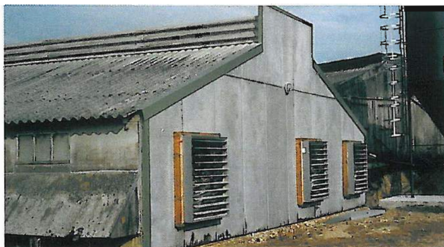
Poulailler équipé de turbines en pignon pour une ventilation d'assistance de type tunnel.
