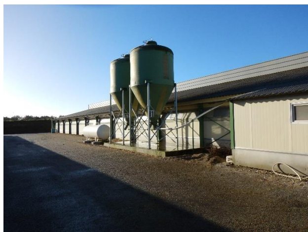
Figure 1 Vue extérieure du bâtiment 1
