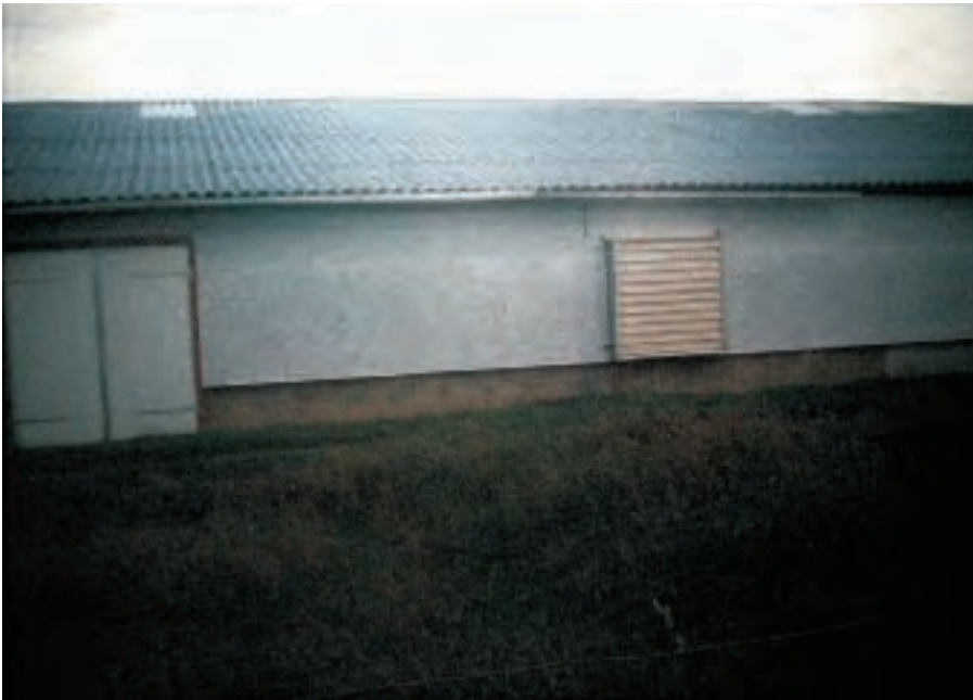
Bâtiment type "Colorado" : comme pour tous les bâtiments un bon réglage des circuits d'air est nécessaire
