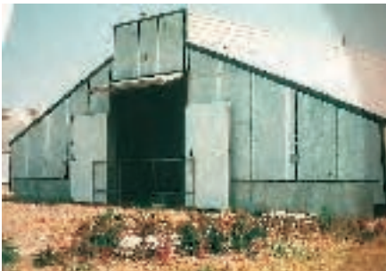
L'ouverture des portails en bâtiments statiques permet souvent d'améliorer le renouvellement, mais nécessite quelques précautions
