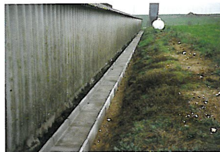
Fossé bétonné en périphérie du bâtiment d'élevage
