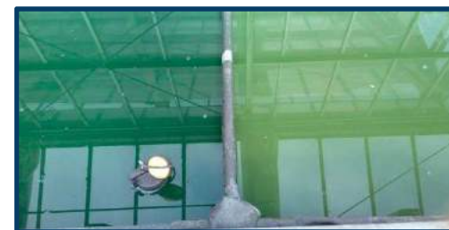
A droite, bassin 2 (alcali) dégradé (photo prise début juillet)
