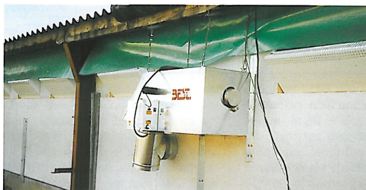
Les aérothermes extérieurs à la salle d'élevage pourraient répondre aux problèmes d'incendie et d'intoxication.
