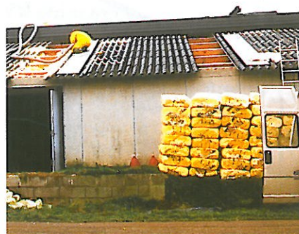
Le rechargement de la toiture peut être réalisé par soufflage
