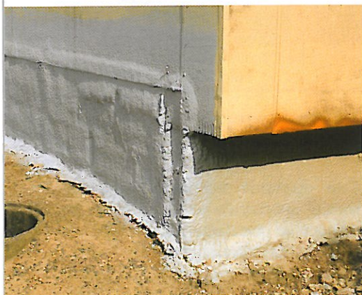
Isolation du soubassement par projection de mousse de polyuréthane.
