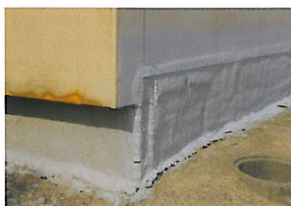
Isolation du soubassement par projection de mousse de polyuréthane.
