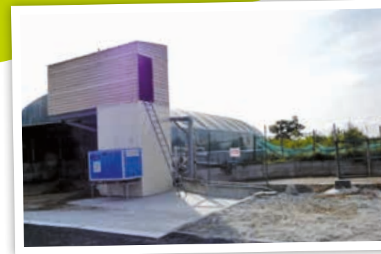
Séparateur de phase chez William et Alain, installé par la SIAC.
