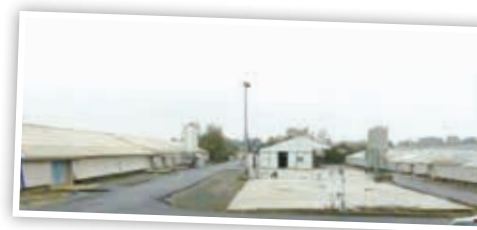
Fosse couverte entre les bâtiments, avec aire de lavage et de caillebotis et de petits matériels.
