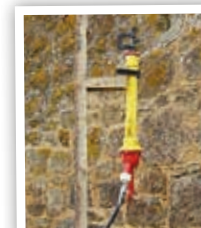
Dispositif d'aspersion pour détremper les cheminées de l'extraction haute.
