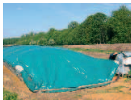
Silo en fonctionnement
