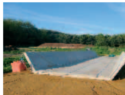
Vue du silo avant son remplissage
