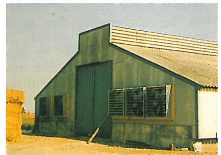
Poulailler équipé de turbines en pignon pour une ventilation d'assistance de type tunnel
