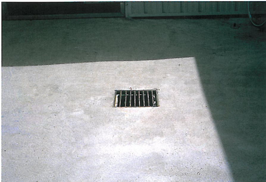
Les aires bétonnées au niveau des entrées et des sorties facilitent le nettoyage
