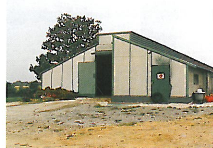
Un diagnostic global du bâtiment doit-être réalisé avant rénovation.
