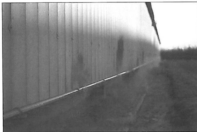
Système de pulvérisation basse pression en fonctionnement
