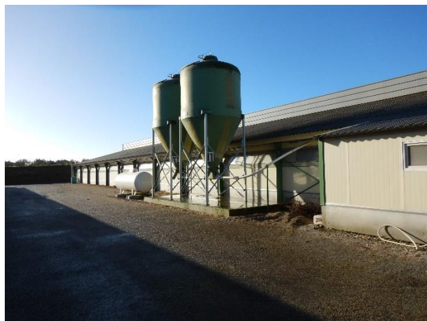
Figure 1 Vue extérieure du bâtiment 1
