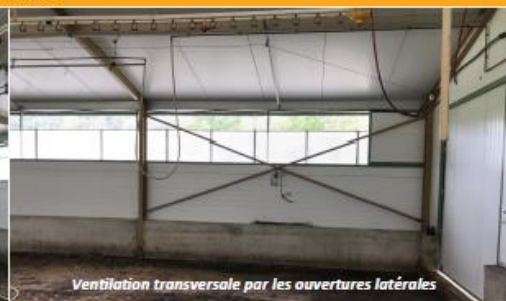
Bâtiment Louiane de 405 m 2 avec un sol en terre battue
