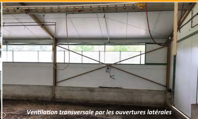
Bâtiment Louisiane de 405 m 2 avec un sol en terre battue
