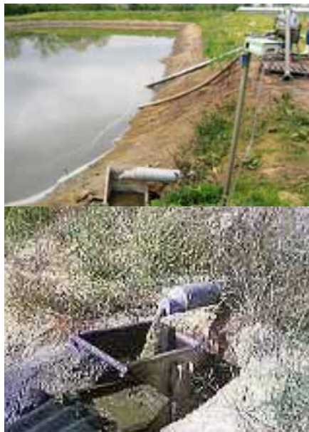
Installation d'un auget basculant
