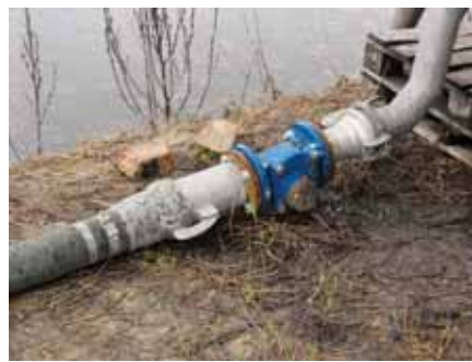
Installation d'un débitmètre sur la canalisation
